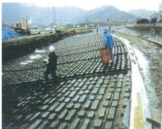
ESPECK®-L을 주입한 후 포러스콘크리트 사이에 흙을 부설
